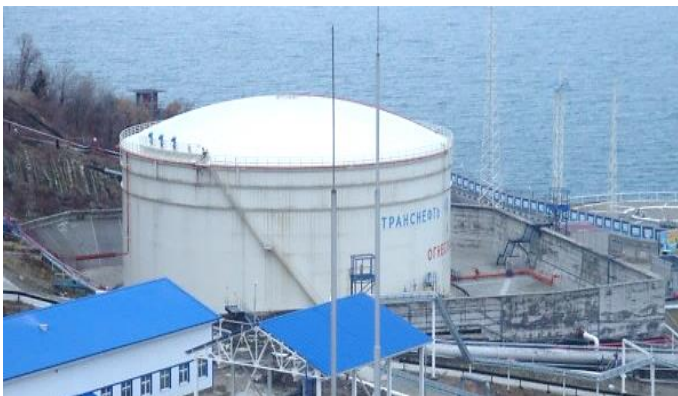
Hình 6: Toàn cảnh đê bao có mái chắn sóng của bể chứa dầu nhiên liệu tại Liên bang Nga.
