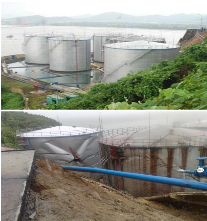
Hình 4: Hình ảnh khu bể chứa trong sự cố tại kho xăng dầu hàng không Liên Chiểu.
