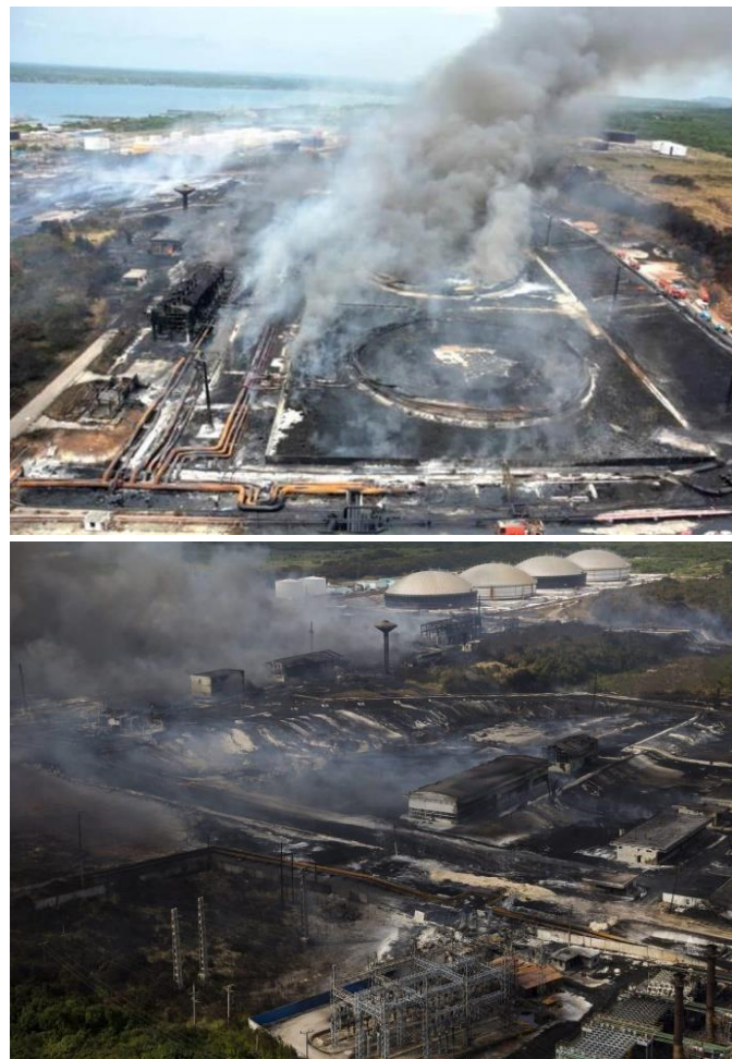
Hình 3: Hình ảnh khu bể chứa trong vụ hỏa hoạn tại Khu Công nghiệp Matanzas.
