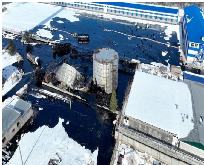
Hình 2: Hậu quả của sự phá hủy bể chứa nhựa đường.
