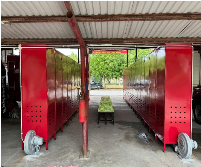
Hình 2: Hình ảnh đầy đủ “Tủ bảo quản trang phục thường trực chữa cháy và cứu nạn, cứu hộ” trang bị tại Đội Chữa cháy và cứu nạn, cứu hộ khu vực 16 - Công an Thành phố Hà Nội có quạt thông gió.
