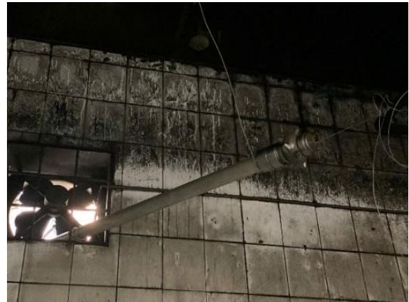
Hình 3: Đưa thiết bị vào qua vị trí đặt quạt thông gió.
