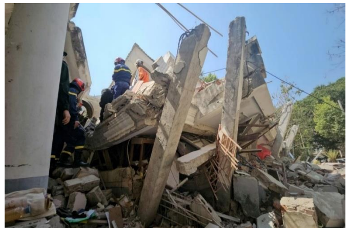
Hiện trường công trình sập đổ do động đất tại Myanmar.
